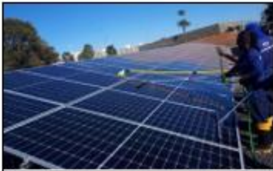
Figura 3 - Limpeza manual dos módulos
