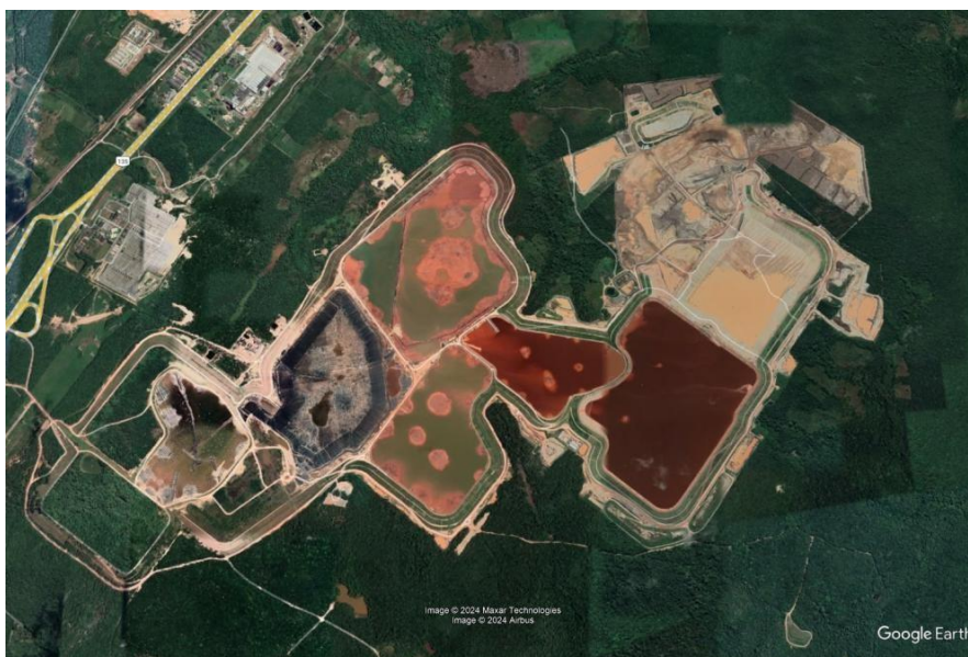
Figura 1 - Área de armazenagem do resíduo de bauxita. Fonte: Google Earth, 2024.
