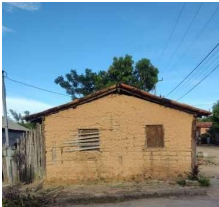
Figura 2: Residência de taipa.
