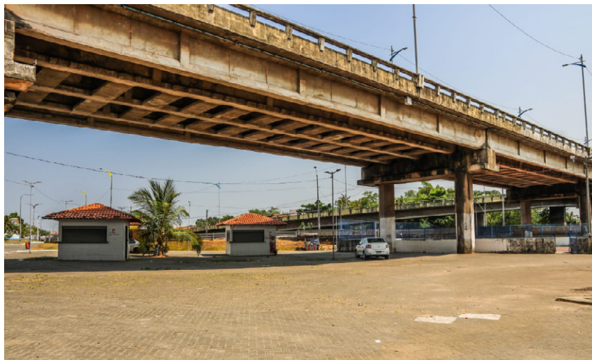
Imagem 24: DRENAGEM ABAIXO DA PONTE BANDEIRA TRIBUZZI - BAIRRO CAMBOA
