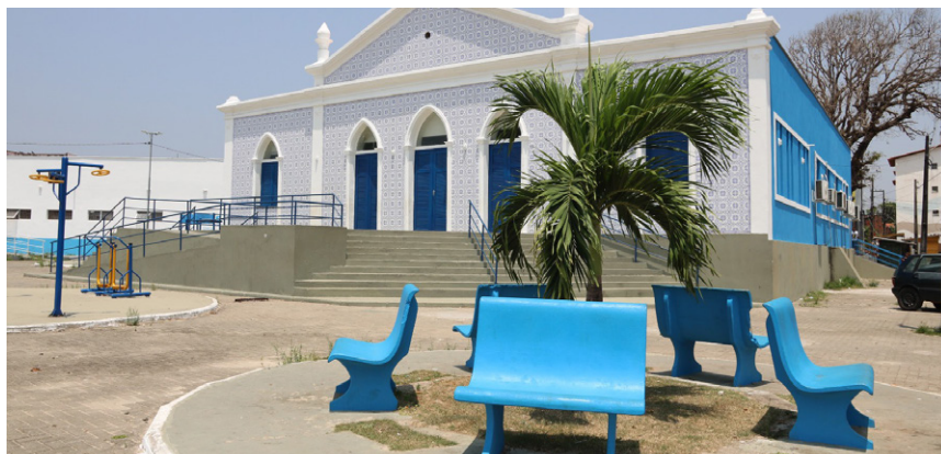
Imagem 22: CENTRO DE TRABALHO NO RESIDENCIAL PAC JACKSON LAGO NO BAIRRO DA FÉ EM DEUS.
