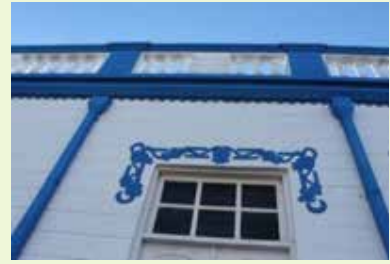
Detalhe da cercadura do edifício eclético.
