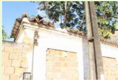
Beiral de telhado de edificação totalmente arruinada.
