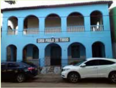
Edifício com características coloniais de dois pavimentos.
