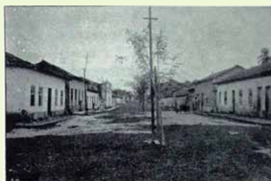
Diferentes momentos da Praça José Sarney em imagens de vários momentos da cidade, com detalhe para as ruas, equipamentos públicos e edificações.
