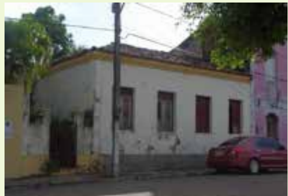
Edificação com beira característica da arquitetura colonial.
