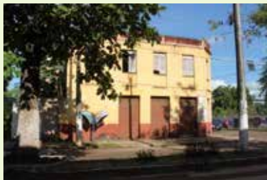
Edifício com características coloniais de dois pavimentos.
