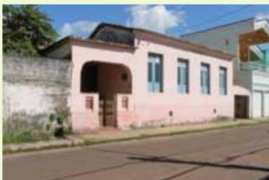
Edificação de um pavimento ainda em uso.
