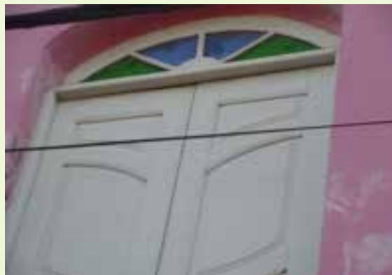
Detalhe do janelão em arco.
