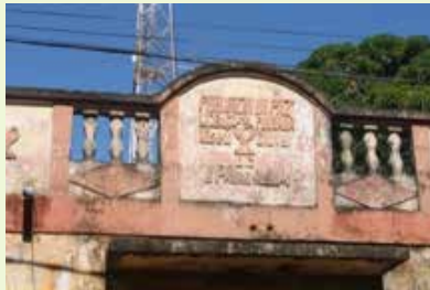
Frontão com a indicação do ano e propriedade da edificação.
