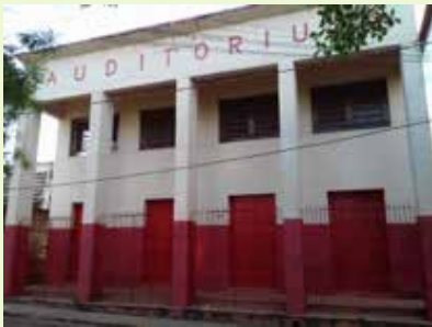
Fachada do Edifício Auditorium com características modernistas.
