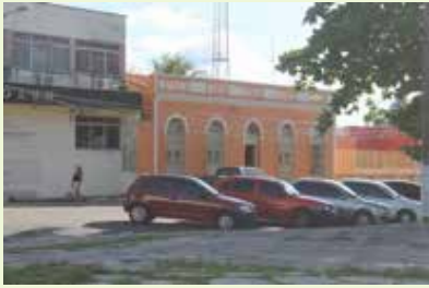
Edifício com características coloniais com um pavimento.
