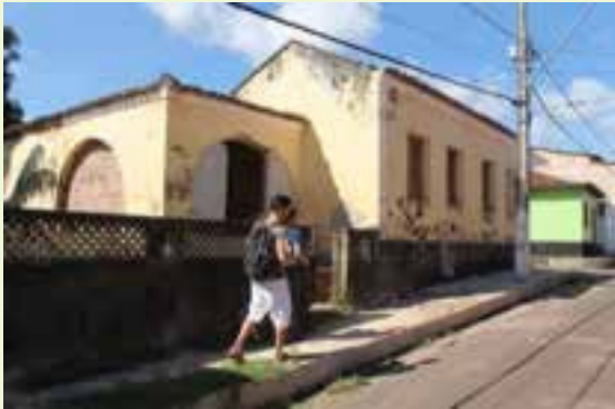
Edificação de um pavimento ainda em uso.
