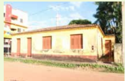
Edifício com características coloniais com um pavimento.
