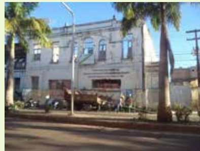
Edifício da Justiça sendo restaurado, apresentando características ecléticas.
