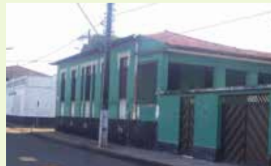
Edifício com características coloniais com um pavimento.
