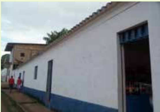
Edificação com beira característica da arquitetura colonial.
