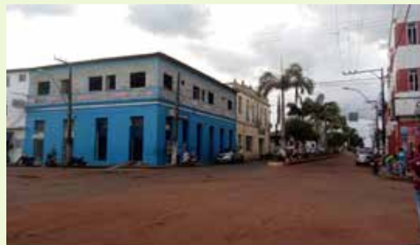
Figura 9 – Edificação eclética de um pavimento alterada com a construção de um piso superior, onde atualmente funciona uma lotérica. Fonte: Valdiney Pereira, 2018.
