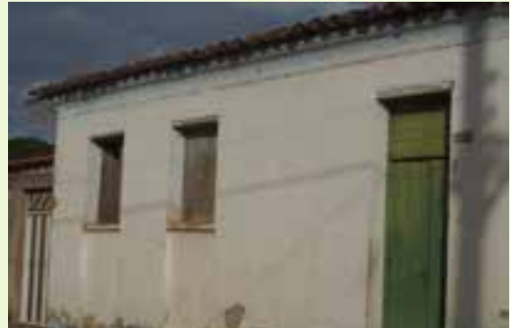
Edificação de meia morada com porta ampliada.
