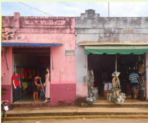
Edificações mais simples com uso como comércio com características de Art Déco.
