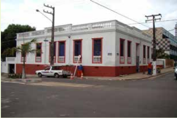
Figura 3 – Prédio de Américo A. Gonçalves reformado para funcionamento do Corpo de Bombeiros de Pinheiro. Fonte: Cortesia da Sra. Sandra Mendes.
