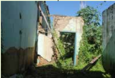
Interior da edificação em ruína.
