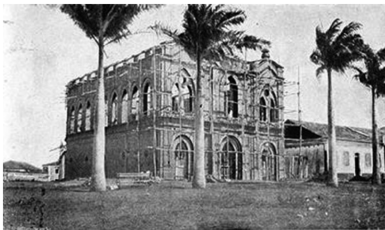
Figura 10 – Reforma da Igreja dos Remédios, s/autor.
