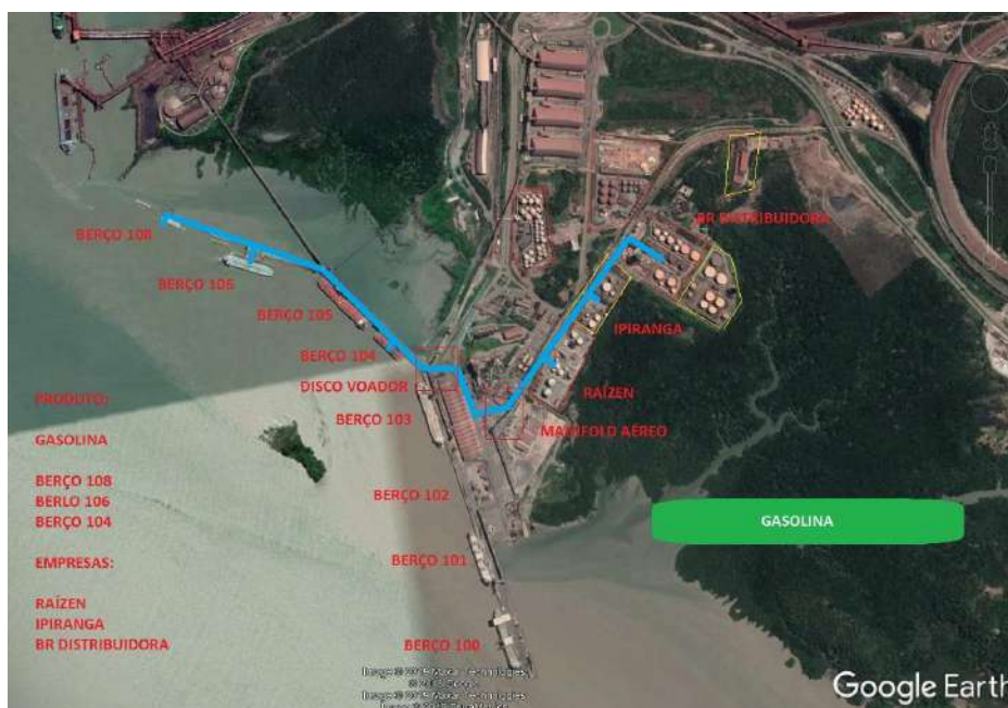
Figura 7. Tubulação de carga e descarga de Gasolina para companhias distribuidoras
