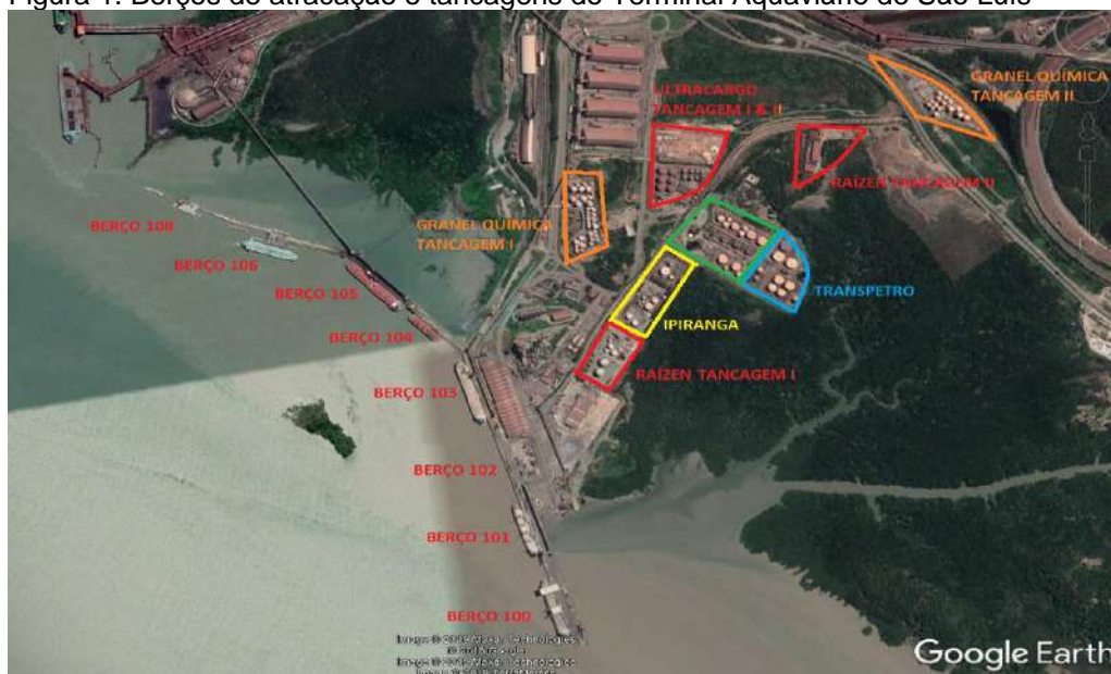
Figura 1. Berços de atracação e tancagens do Terminal Aquaviário de São Luís
