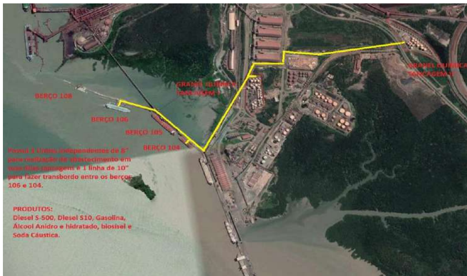
Figura 13. Tubulação de carga e descarga da Granel Química
