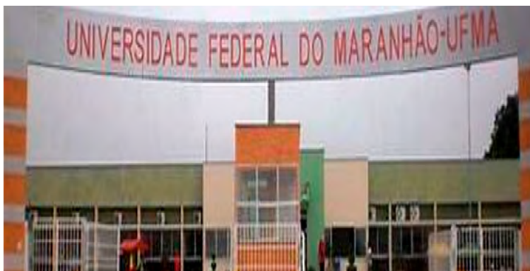
Fotografia 2: Fachada Campus UFMA Grajaú-MA
