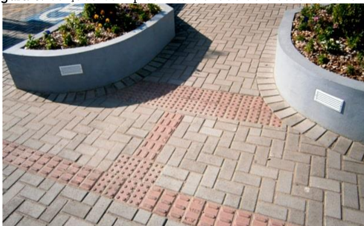
Figura 9: Calçada com piso intertravado de blocos de concreto.
