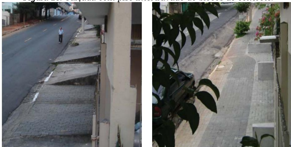
Figura 10: Calçada com piso intertravado de blocos de concreto.
