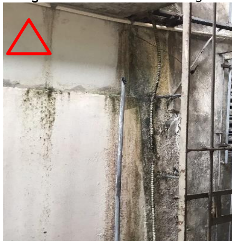
Figura 11: Base da caixa d'água.
