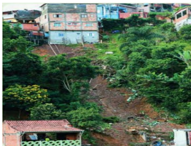
Figura 4: Casas destruídas por deslizamento de terras em consequência das fortes chuvas, em Mairiporã, SP (2016). Observe que as construções localizam-se em área de risco.
