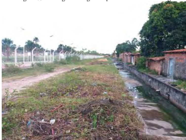
Figura 03 – Fotografia da galeria para o escoamento de água
