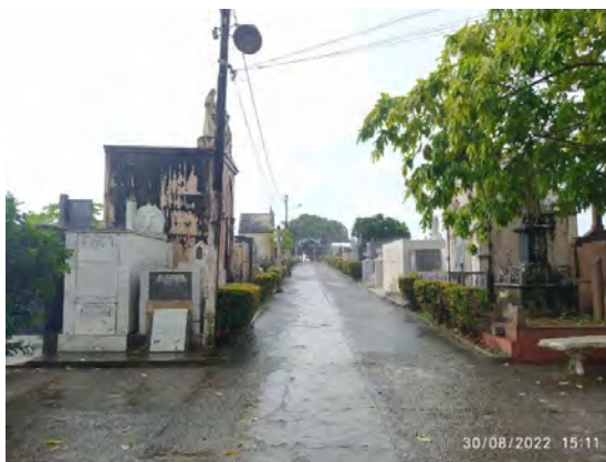
Figura 6: Entrada da Capela de São José
