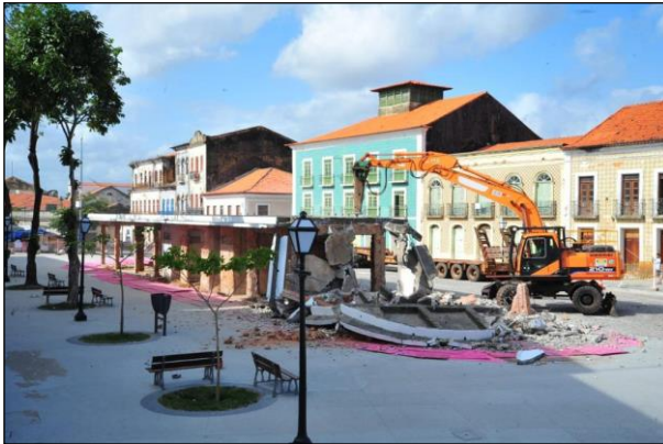
Figura 5 - Demolição do abrigo da Praça João Lisboa
