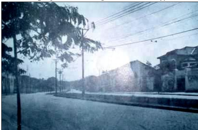
Figura 5 – Avenida Getúlio Vargas em São Luís nos anos 1940.
