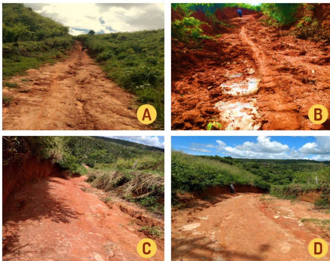
Figura 14: Imagem das vias vicinais (Fig. 14 A, B, C ligam o povoado de cajazeiras as roças na chapada e (Fig. 14 D) liga a sede do município a vila Alberto no município de Arame (MA, Brasil), por onde trafega a produção.
